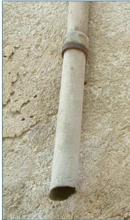
Abb. 2 und Abb. 3: Beispiele für asbesthaltige Bauteile: Aschenbecher, Blumenkasten, Regenabflussrohr.
