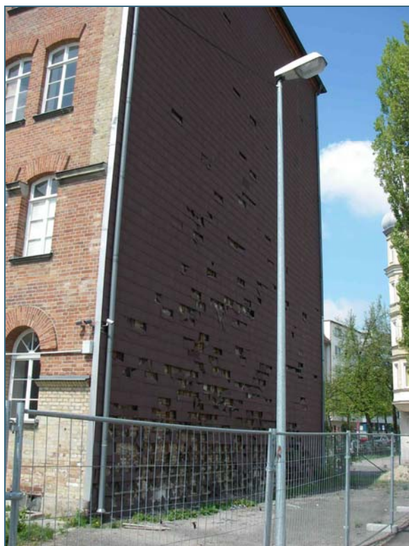
Abb. 5: Beschädigte Asbestplatten
