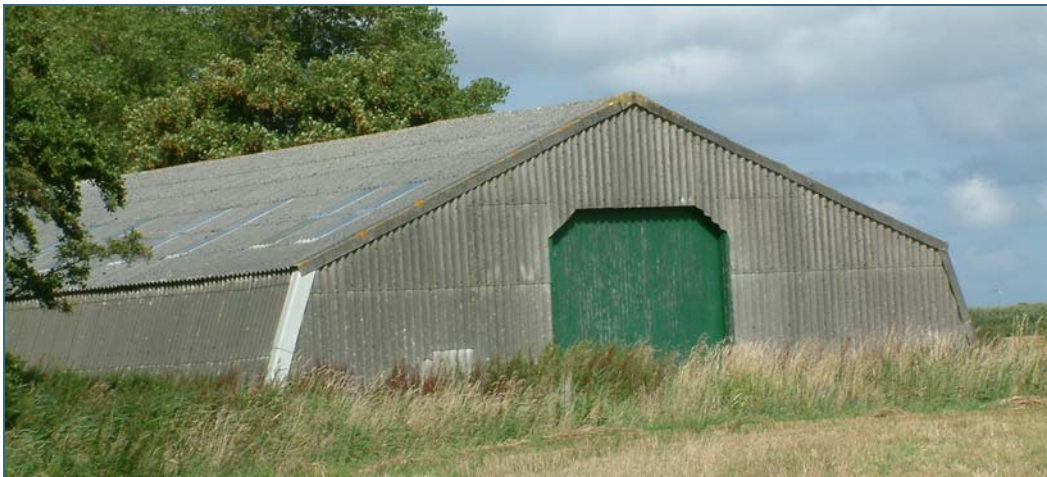
Abb. 1: Asbestos – griechisch für „unvergänglich“. Aber nicht unproblematisch. Im Bild eine Scheune, die vollständig mit Wellasbest verkleidet wurde.
