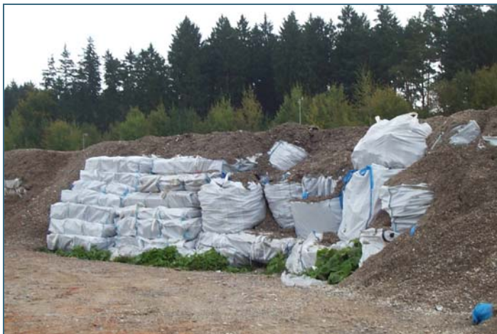
Abb. 9: Teilweise abgedeckte Big-Bags in einer Deponie
